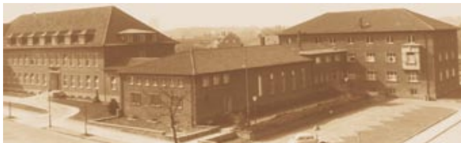
Historische Aufnahme des früheren Gebäudes des Silikoseforschungsinstituts (SFI)
